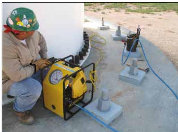
◀ *La centralina ZUTP-1500 risulta quindi resistente, leggera, compatta e in grado di entrare nelle aperture più strette, nonché di garantire un funzionamento semplice e di effettuare il tensionamento dei bulloni in posizioni remote a una velocità massima doppia rispetto a quella offerta dalle centraline della concorrenza.*
